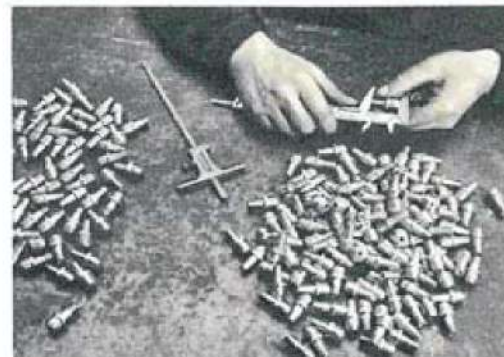
Contrôle individuel des injecteurs différentiels des brûleurs « Multigaz ».
